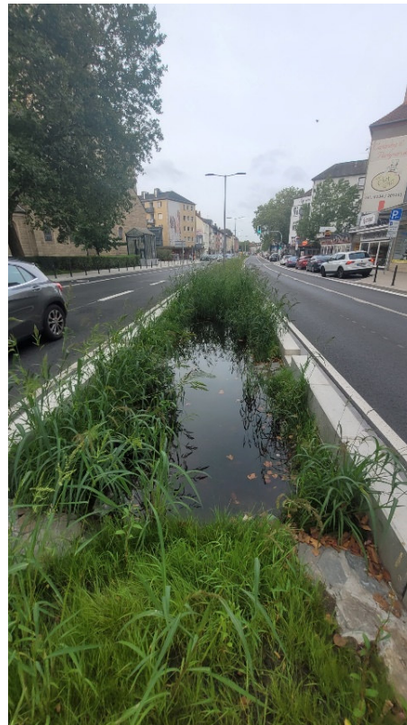
Abb.: Rigolen und Mulde in Mittelachse Hattinger Straße
