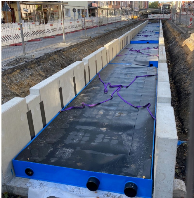
Abb.: Rigolen und Mulde in Mittelachse Hattinger Straße
