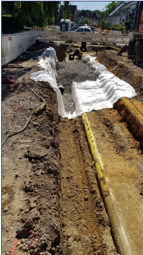
Abb.: Herstellung Rigolen / Baumrigolen, Drosselschacht
